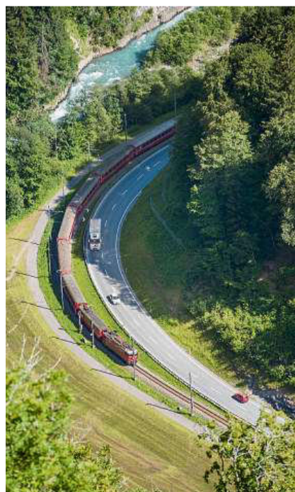
Soll verschwinden: Der Veloweg zwischen Fideris und Küblis soll nach dem geplanten Ausbau der Nationalstrasse über die Lokalstrasse geführt werden. Bild Olivia Aebli-Item
