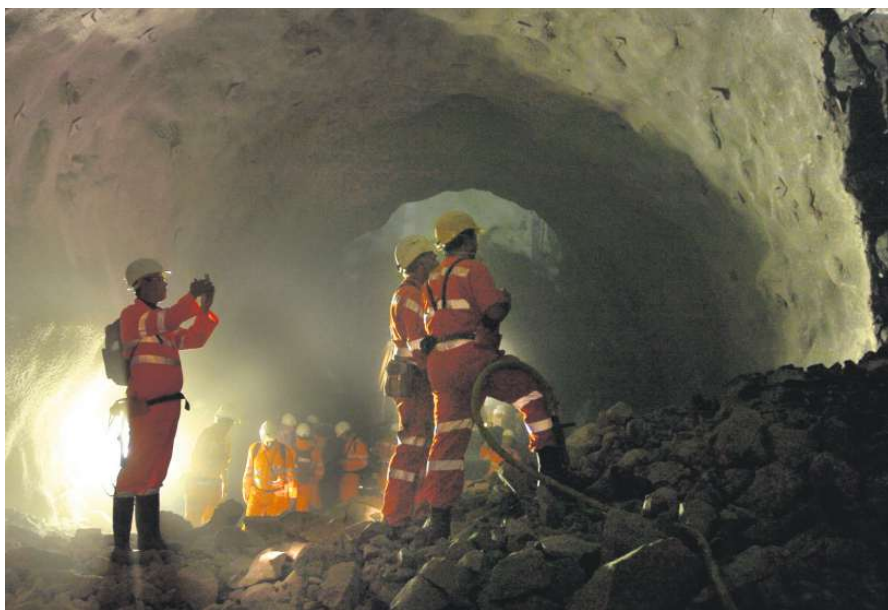
Arbeiter begutachten das Gestein nach der ersten Sprengung für die Porta Alpina im Oktober 2006.
